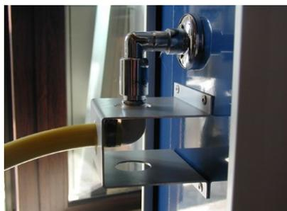
Entsorgungsseite für Anschluss Spülschlauch mit Rohrunterbrecher Bauform A1 *siehe unten!*
